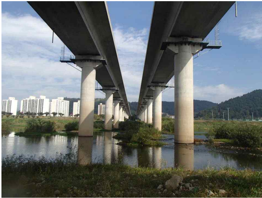
PSC Box Girder 외부 전경
