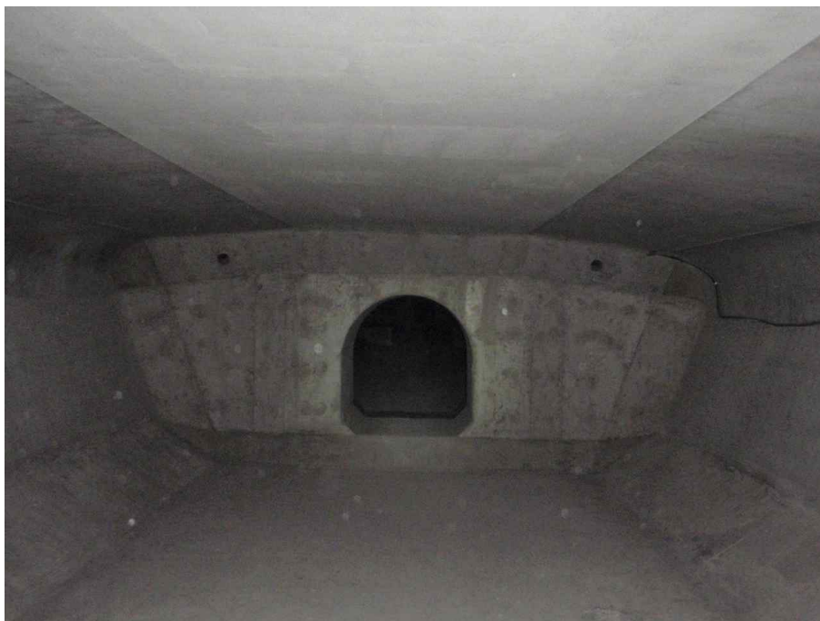
PSC Box Girder 내부 전경
